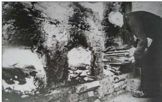
Ovenfor: Robert Dissing fyrer i den gamle ovn på Banevej i Hansted. Foto formentlig fra 1940'erne.
