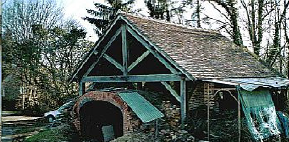
60 m 3 traditionel ovn i La Borne som stadig bruges til fællesbrændinger
